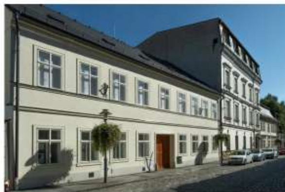
Dům čp. 72 ve Skálově ulici, Turnov
